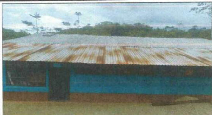
Foto 1: SUSTITUCION DE LAMINAS EN AULAS EN MAL ESTADO
