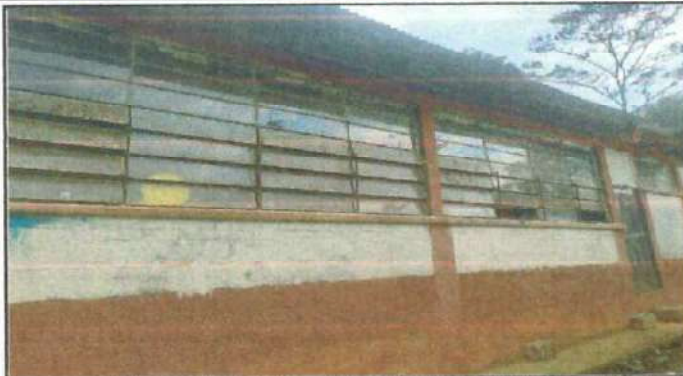
Foto 2: SUSTITUCION DE ESTRUCTURA METALICA Y VIDRIOS EN MAL ESTADO
