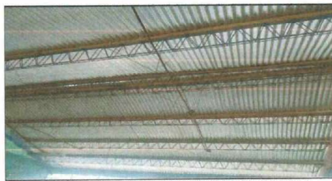
Foto 6: SUSTITUCION DE COSTANERAS EN MAL ESTADO DE AULA
